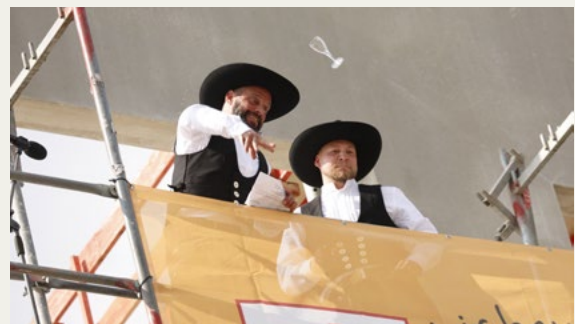
Poliere nach dem Richtspruch
