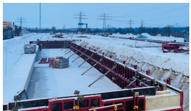
Hier steht in wenigen Monaten das Parkhaus mit 7 Etagen
