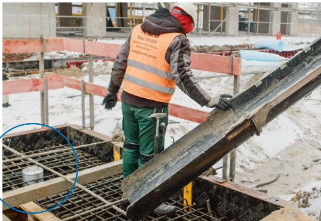
Die Zeitkapsel wird eingebaut
