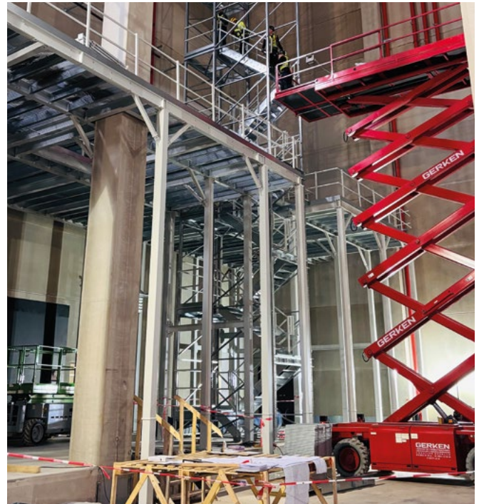
Der Innenausbau des Lagers hat begonnen
