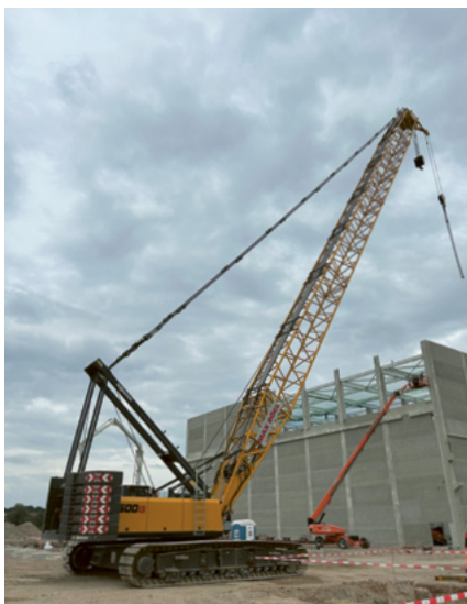
Raupenkran Sennebogen 5500 G
