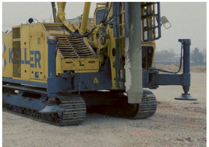
Rüttelstopfmaschine im Einsatz.
