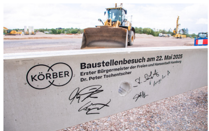
Das signierte Bauteil wird Teil der Dachkonstruktion.
